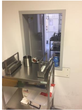
Durchreiche für die fertigen Radiopharmazeutika
