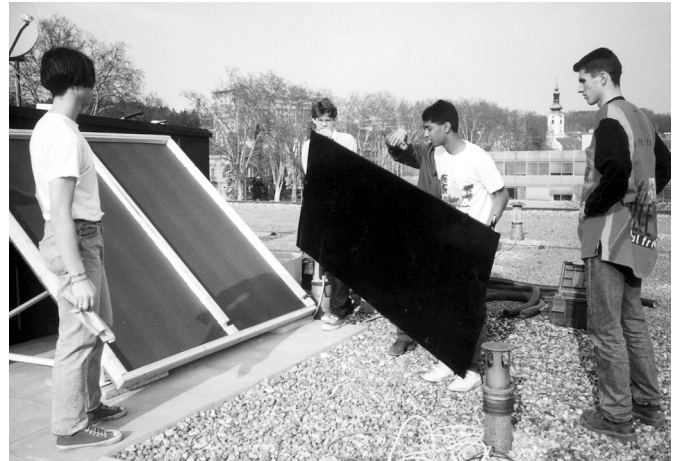
Abb. 5: Der Einbau des Absorbers in den Holzrahmen
