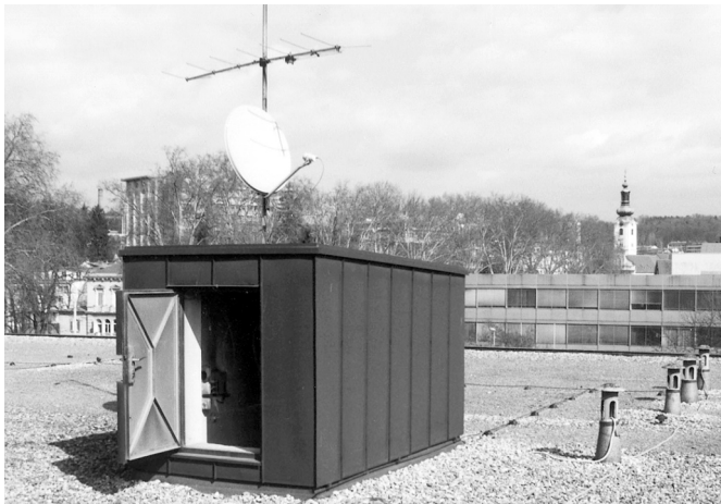
Abb. 4: Das "leere" Dach
