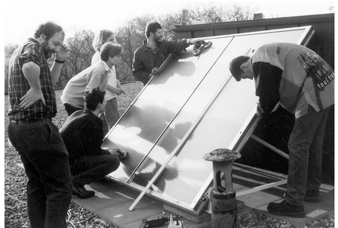
Abb. 6: Fertigstellung der Glasabdeckung
